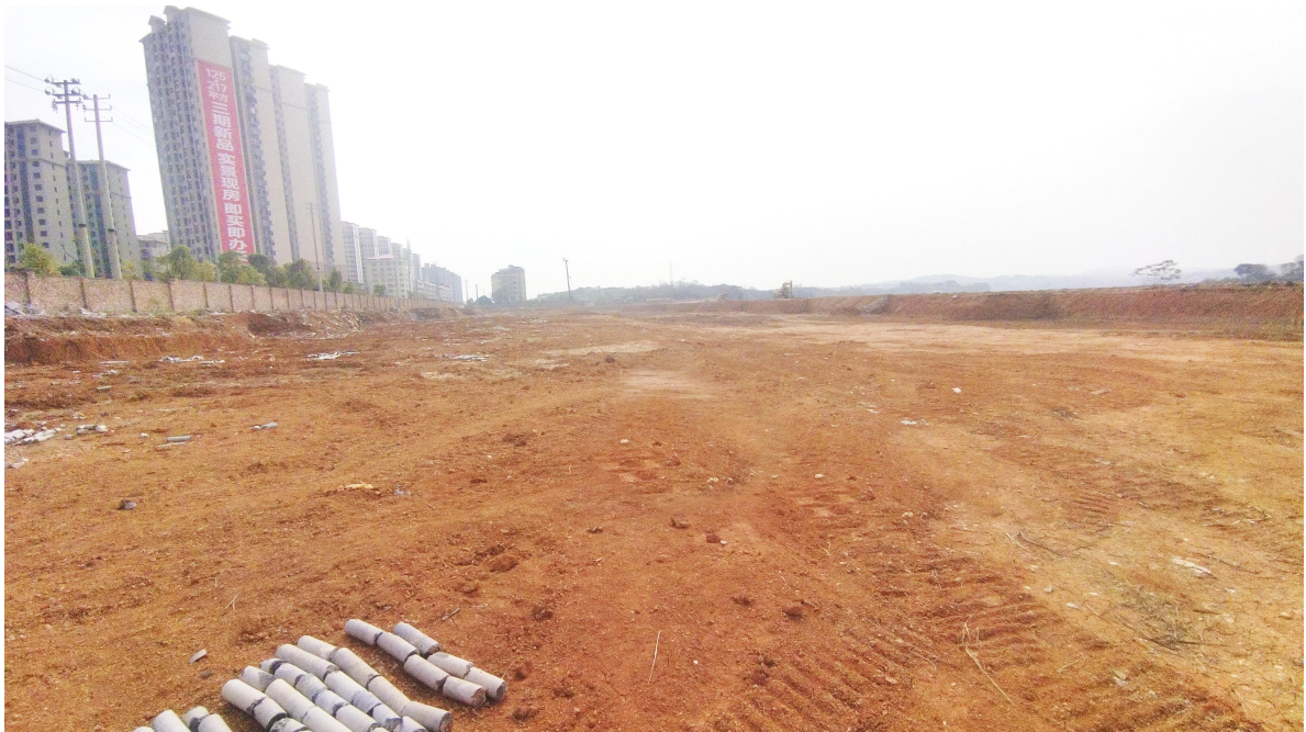
图 3.3-2 地块现状：初步完成土方开挖作业
