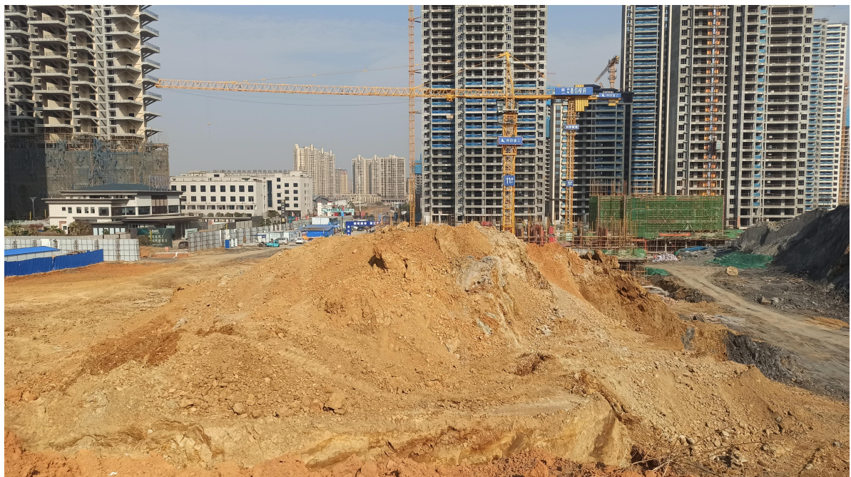
图 3.3-2 地块现状：地块南部正在进行土方开挖作业
