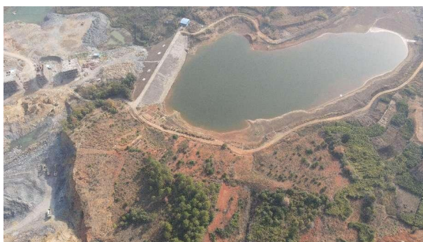
图 3.4-4 南侧：均塘冲水库及山林地
