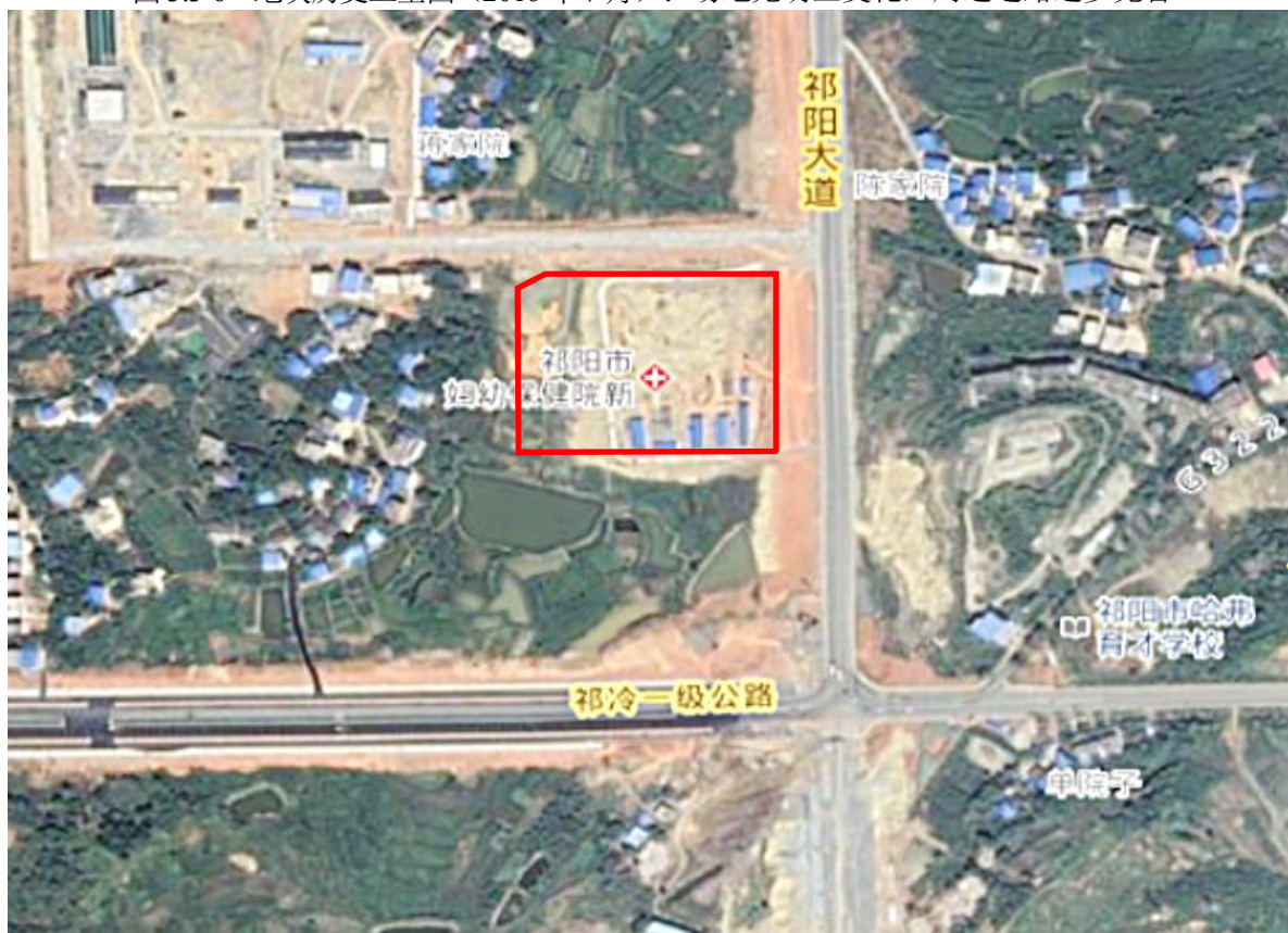
图 3.3-7 地块历史卫星图（2017 年 9 月）：场地土方开挖平整
