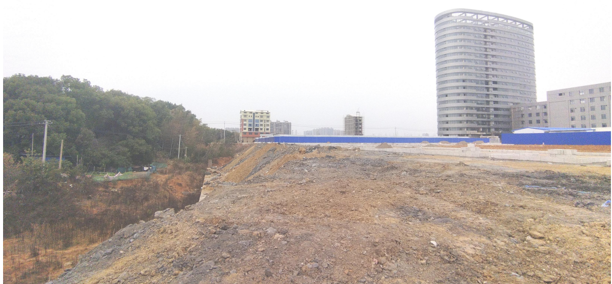
图 3.3-2 地块现状：方舱医院正在施工
